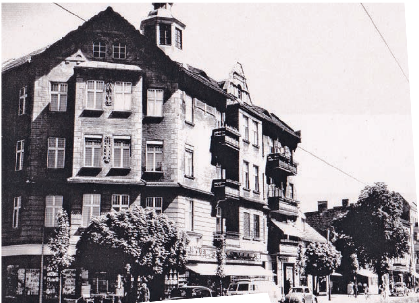
Alte Pracht der Resi Fotos: Museum Reinickendorf
