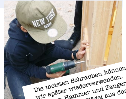
Mit Bohrmaschinen und Schraubendreher werden alte Schrauben entfernt.
